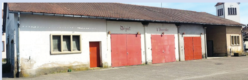
Vue de l'ancien dépôt d'incendie avant sa transformation
