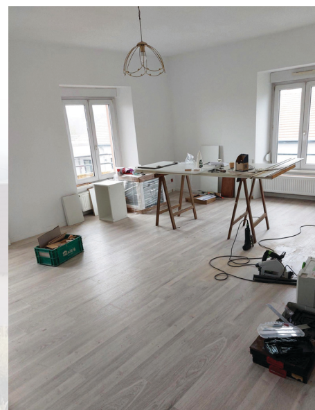
Travaux de réfection d'un logement situé au-dessus de l'ancienne poste
