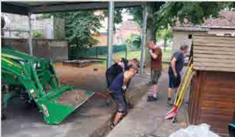
Réalisation d'un caniveau sous le préau à l'école maternelle
