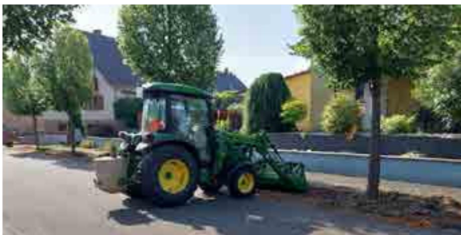
Début de réaménagement des espaces verts de la rue des Tilleuls
