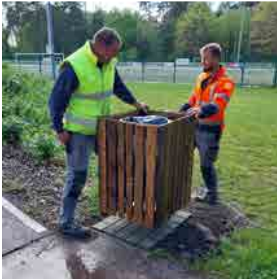
Pose d'une poubelle à l'aire de jeux réalisée par les agents communaux
